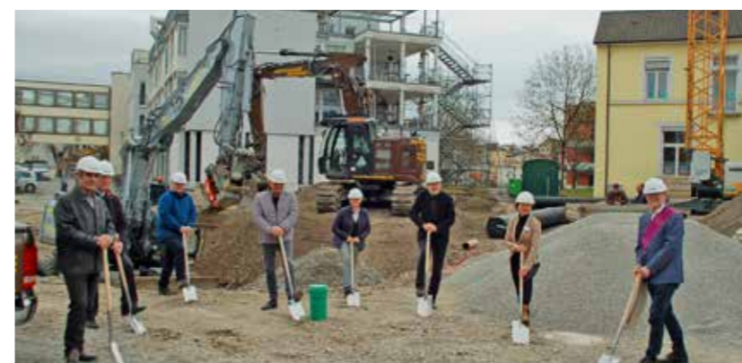
2021 • Spatenstich für das Erweiterungsgebäude 2021
