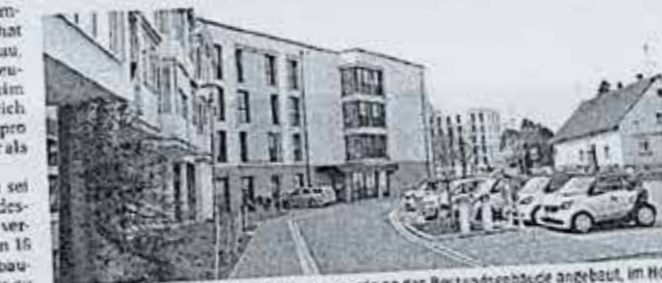
Der Anbau des Pflegezentrums St. Verena wurde an das Bestandsgebäude angebaut, im Hof stehen die E-Fahrzeuge der Sonalstation.
