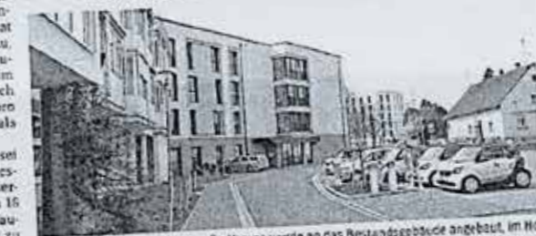
Der Anbau des Pflegezentrums St. Verena wurde an das Bestandsgebäude angebaut, im Hof stehen die E-Fahrzeuge der Sonalstation.
