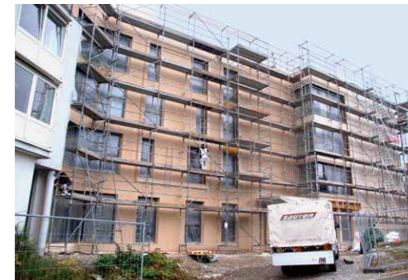
Verputzen der Aussenfassade
