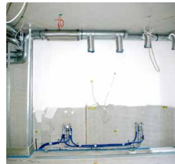
Rohinstallation für Küchenbereich
