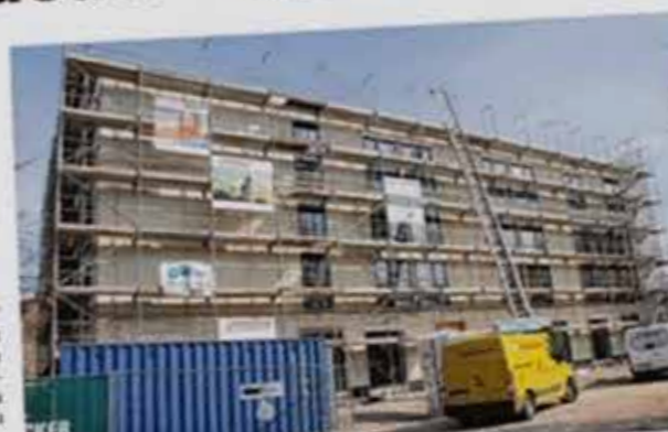
Die Kosten für den Anbau am Pflegezentrum St. Verena betragen sich auf 11,5 Millionen Euro, eine Fertigstellung ist für Ende des Jahres geplant.
