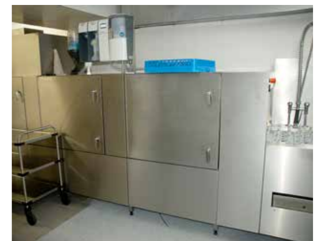
Küche nach Einbau der neuen Spülmaschine
