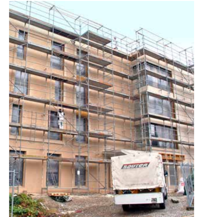
Verputzen der Aussenfassade
