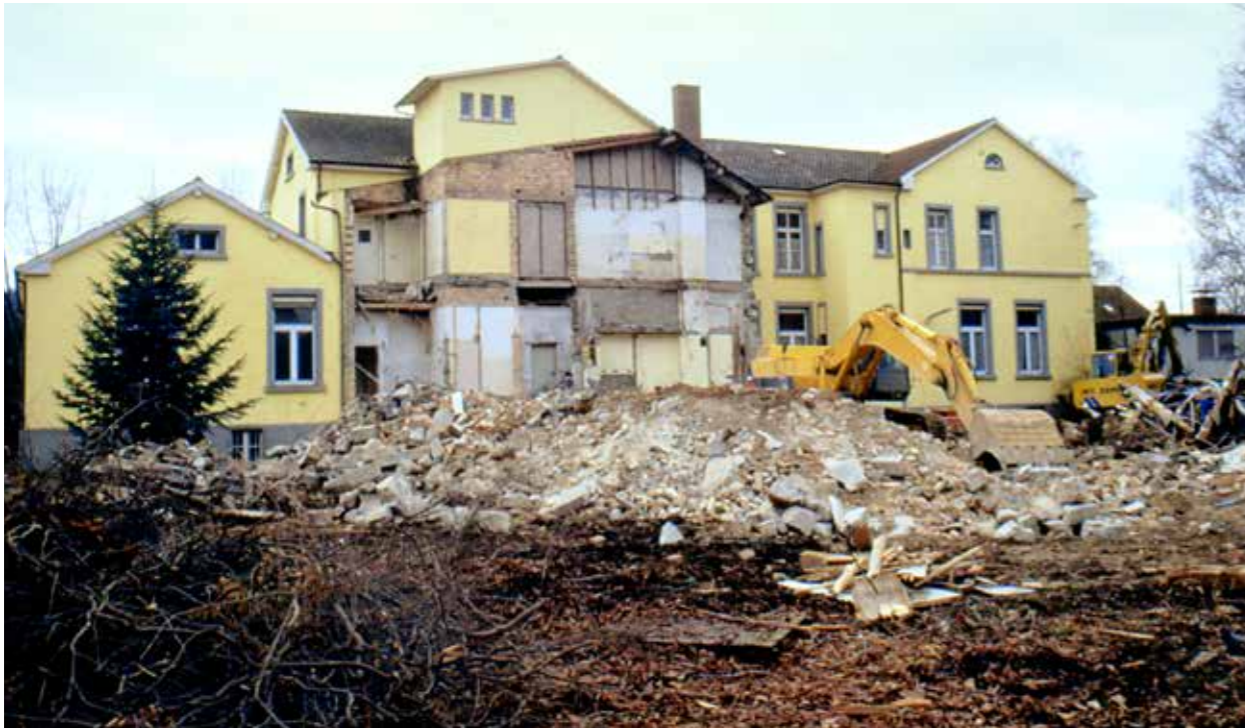
Abbruch des hinteren Trakts des ehemaligen Krankenhaus Heinrich Hospital etwa 1993/1994
